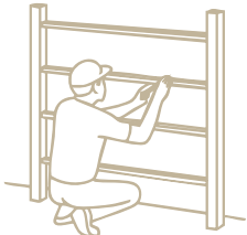
ติดตั้งโครงรับ
